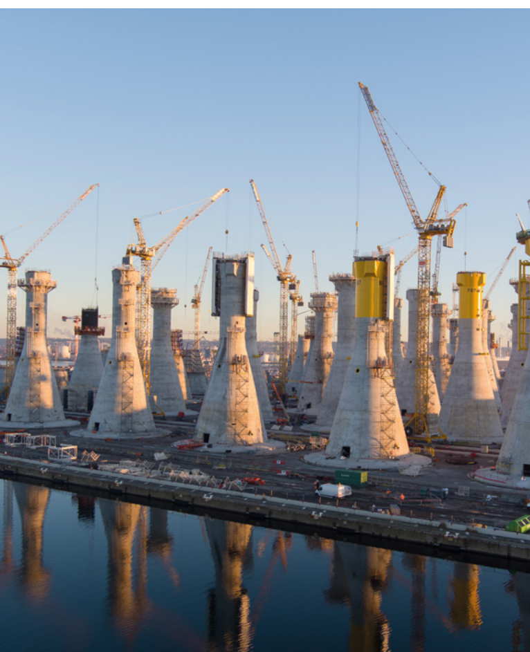
Chantier des fondations gravitaires au Havre
