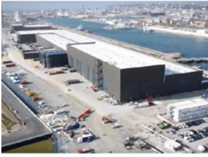
Usine de Siemens Gamesa au Havre
