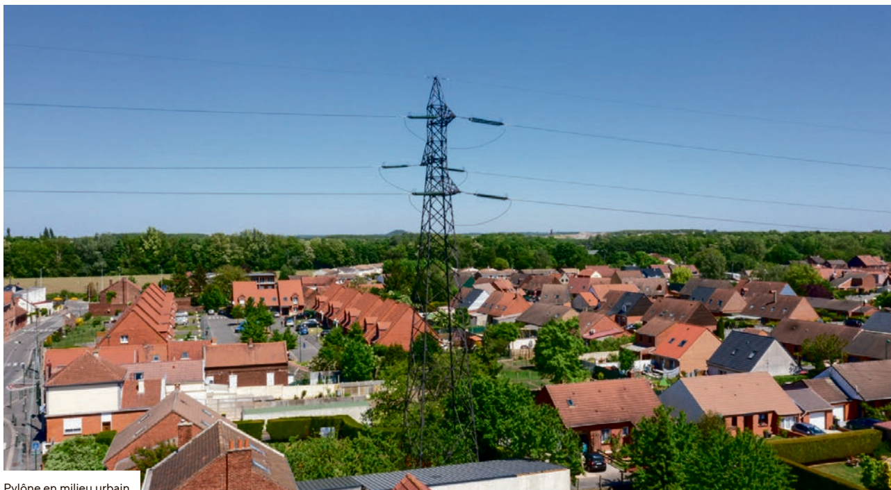
Pylône en milieu urbain
