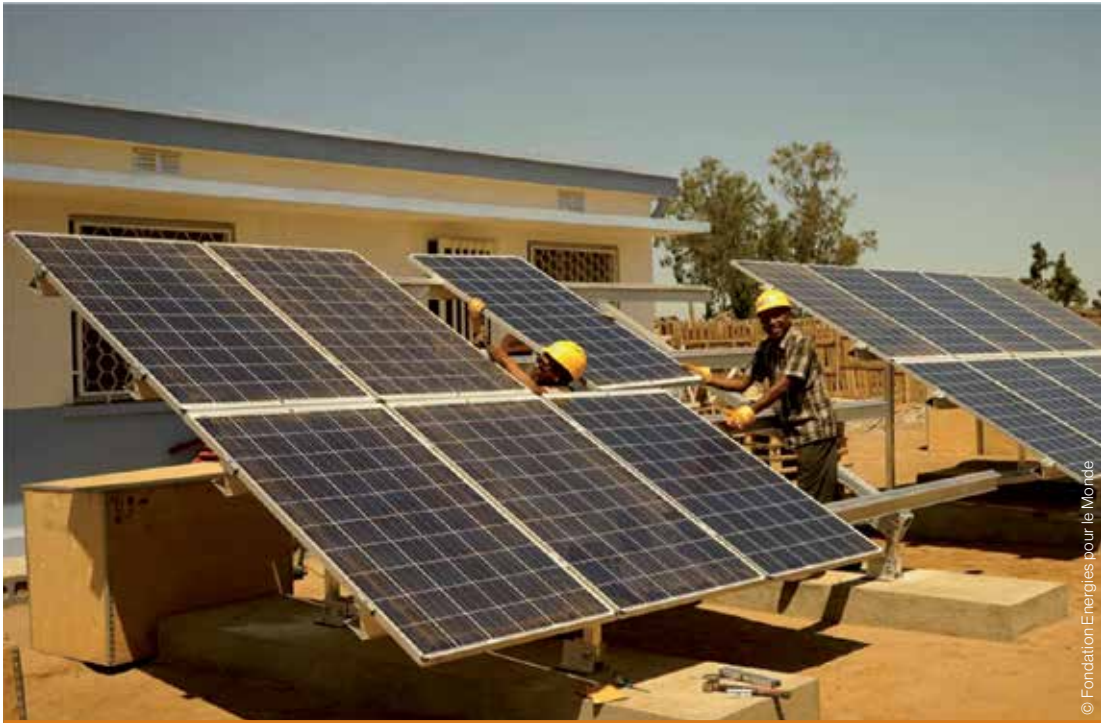
Installation d'une minicentrale solaire au sud de Madagascar.
