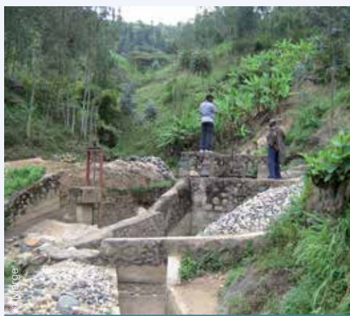
Travaux pour la construction d’une micro centrale hydroélectrique dans le cadre du projet PSP hydro au Rwanda
