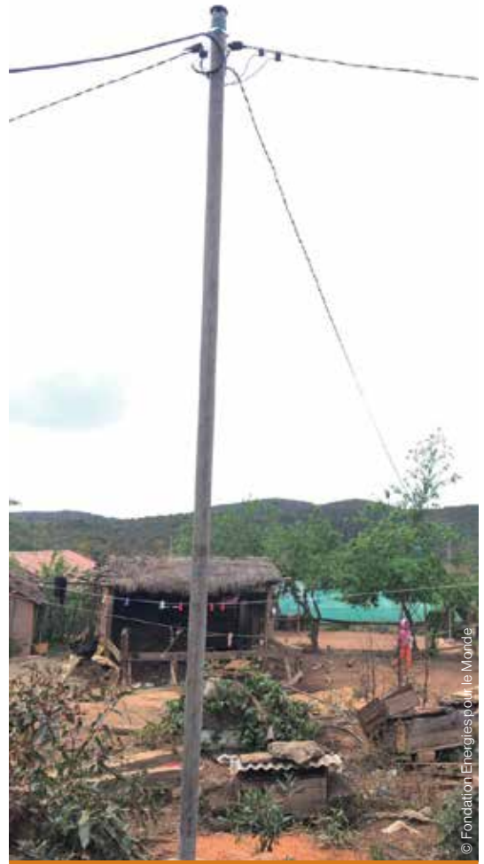
Poteau en béton.
