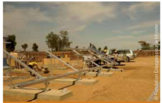
Installation d'un miniréseau à Madagascar.
