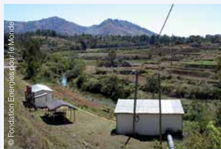
Microcentrale hydraulique d'Antetetzambato.
