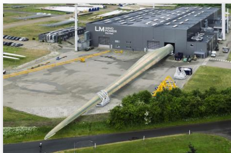
Usine LM Wind Power à Cherbourg (Manche)
