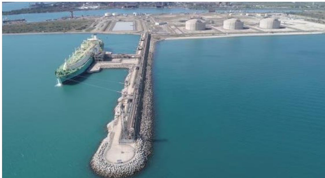
Déchargement d'un méthanier au terminal de Fos Cavaou © Elengy – Vincent Tricart Dronimages
