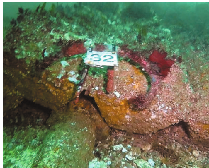
Installation de Paimpol Bréhat, matelas de béton protégeant le câble de raccordement trois mois après l'installation (à gauche) et deux ans après l'installation (à droite).
