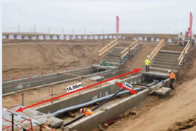
Exemple de chambre de jonction 400 000 volts
