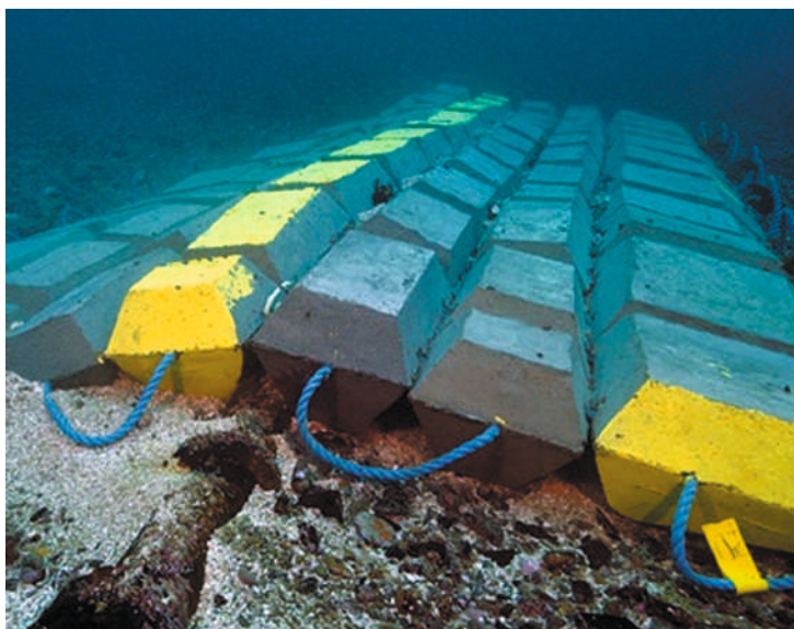
Installation de Paimpol Bréhat, matelas de béton protégeant le câble de raccordement trois mois après l'installation (à gauche) et deux ans après l'installation (à droite).
