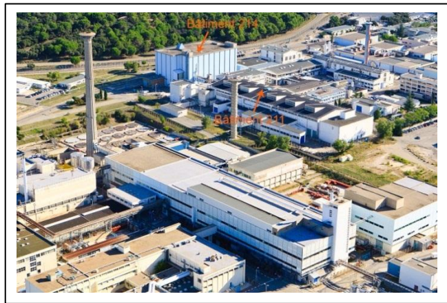
Figure 2- 8 : Chaîne TOR avec les bâtiments 214 et 211 de l'APM à Marcoule
