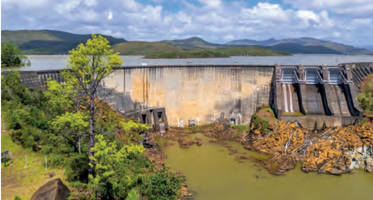
Le barrage hydro-électrique de Yaté (3'6 Film Production - Paul Delecour).
