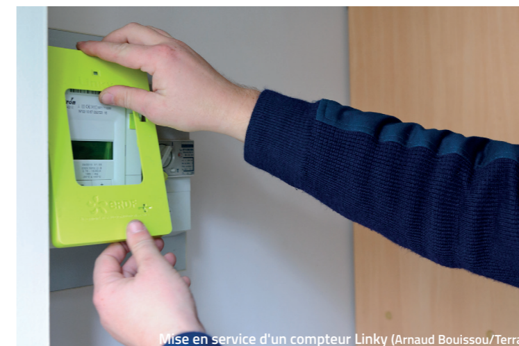
Mise en service d'un compteur Linky (Arnaud Bouissou/Terra)
