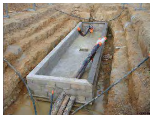
Figure 23 : Exemple d'une chambre de jonction
