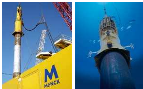
Figure 16 : Marteau hydraulique et battage de pieux sous-marins 3
