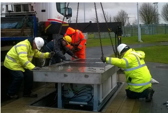
Figure 51 : Système de recharge des batteries par induction
