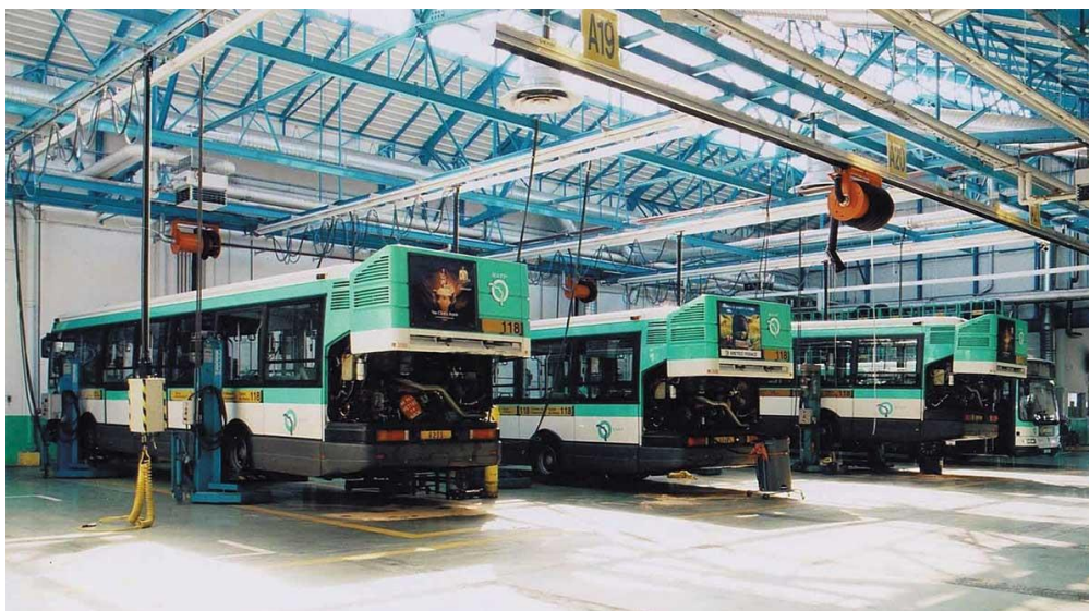
Figure 35 : Atelier de maintenance RATP
