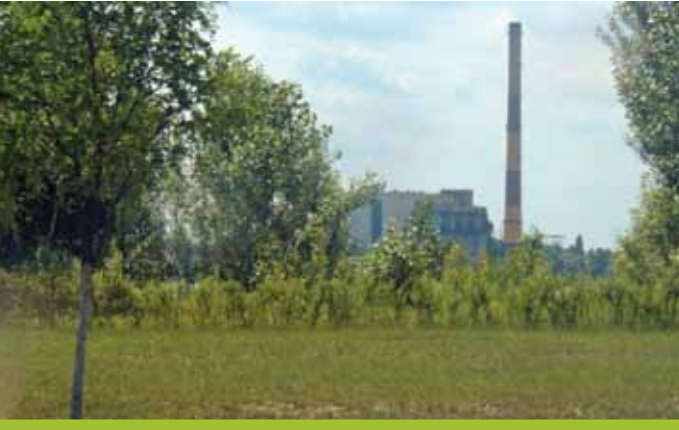
// Usine d’incinération proche de Kyiv.
